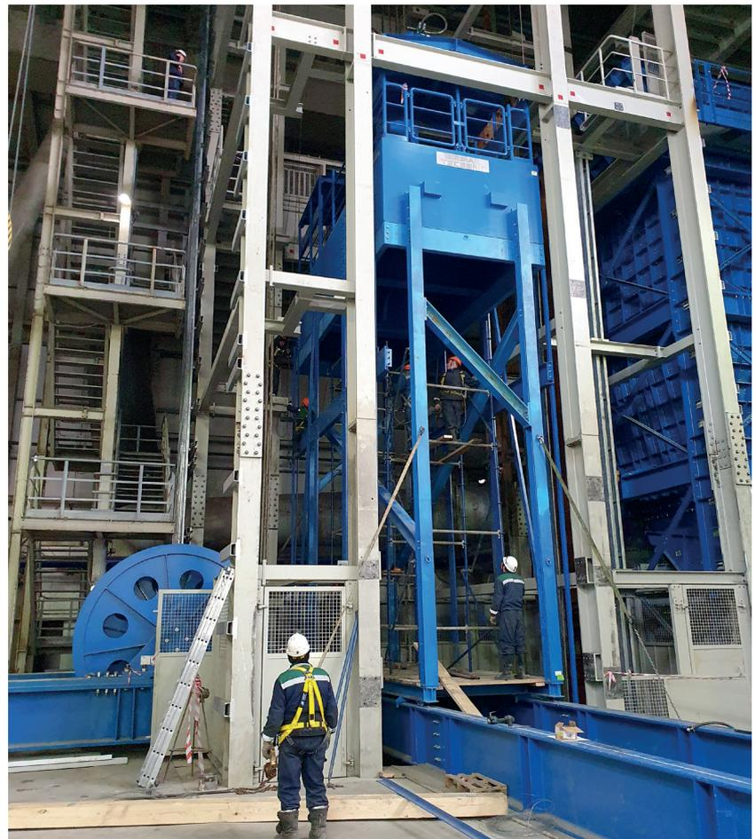
Bild 4: Förderkorb (noch ohne unteren Boden) im Fördergerüst, links davon eine vertikale Umlenkscheibe, rechts davon der Entladebunker für die Skipförderung. Unter dem Korb teilweise sichtbar der Korbeinbauträger.
