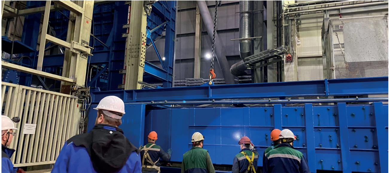
Bild 8: Mittels des Schachthallenkrans, welcher am Einbaurahmen des Skips befestigt wird, erfolgt eine genaue Positionierung des Skips vor dem Fördergerüst.
