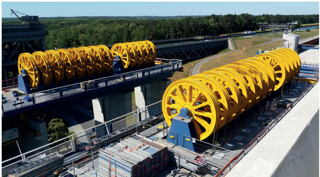
Вид на часть из 112 установленных спаренных шкивов. На заднем фоне слева - старый судоподъемник.
