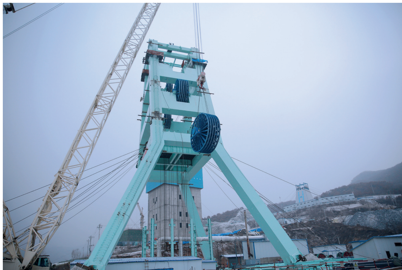
Rys. 1: Rozpoczęcie montażu na miejscu budowy wraz z zamontowaniem kół linowych w kopalni Sishanling. Copyright 2022 Tianjin SIEMAG TECBERG.
