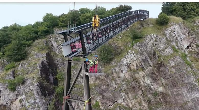
**Bild 5:** Projekt Flémalle: Befestigung schwebender Elemente des Förderers an der Stahlkonstruktion mit zentimetergenauen Montagemanövern
