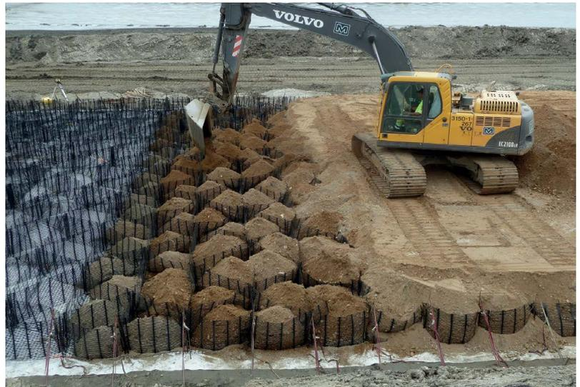
**Bild 6:** Direkt nach dem Einbau befahrbares Geozellensystem
