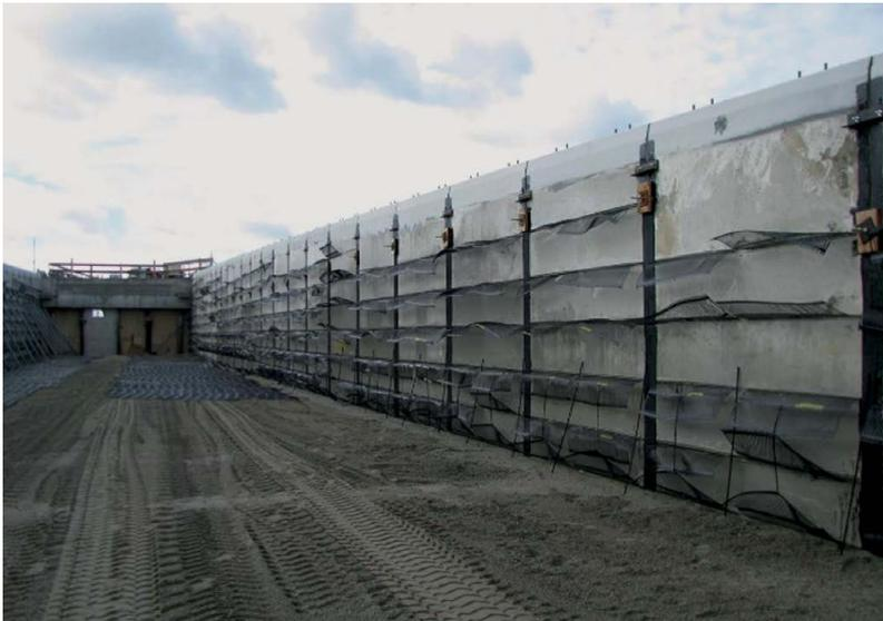
**Bild 9:** KBE mit Betonpaneelen
