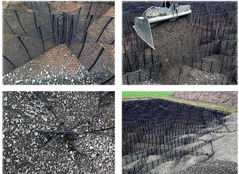
**Bild 7:** Einbau eines räumlichen Gründungssystems aus Geogittern und Füllboden
