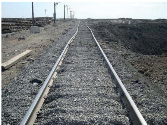
**Bild 4:** Verformtes Gleis
