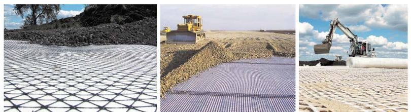
**Bild 2:** Anwendungsbeispiele mit unterschiedlichen Geogittern
