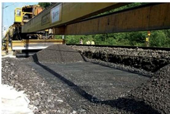
**Bild 5:** Einbau eines Geogitters in einer Gleisanlage
