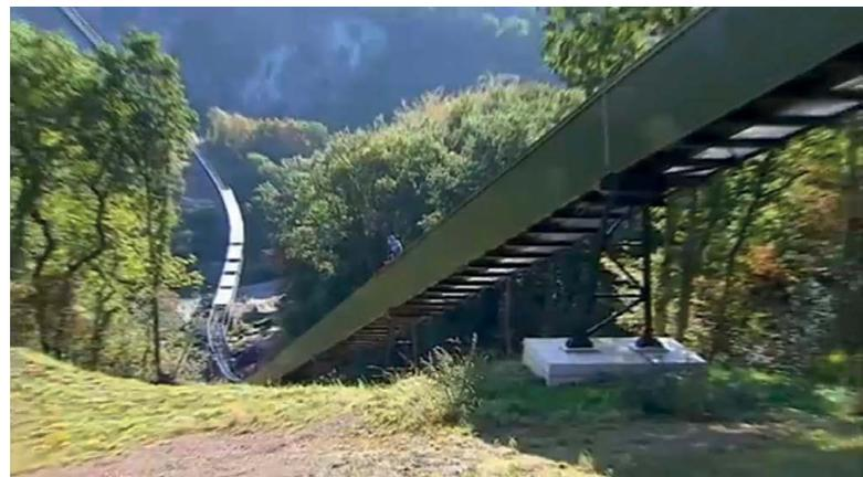
**Bild 6:** Projekt Flémalle: Streckenverlauf des Förderers mit großen Steigungen und großem Gefälle im Bereich steiler Felsen
