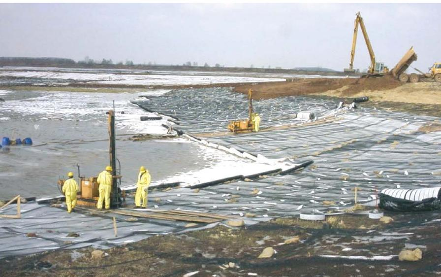
**Bild 10:** Sichere Arbeitsplattform bei einem Absetzbecken
