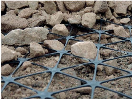
**Bild 2:** Verzahnungsmechanismus zwischen Schüttmaterial und Geogitter
